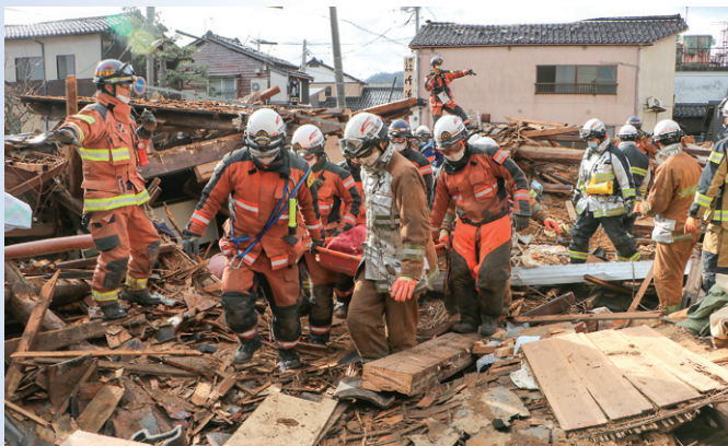
河井町 (大阪市消防局撮影)
